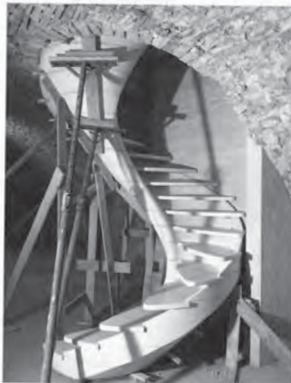
MONTAGGIO DI UN INTERPIANO
